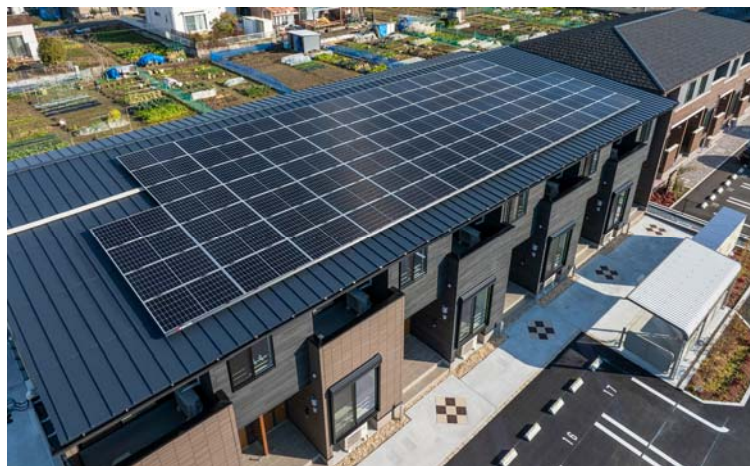
太陽光発電設備を搭載した大東建託の ZEH 賃貸住宅
