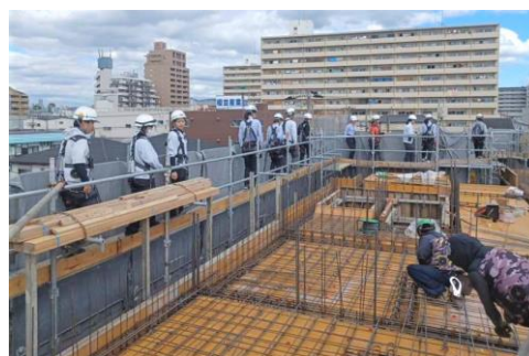
躯体工事の様子を見学
