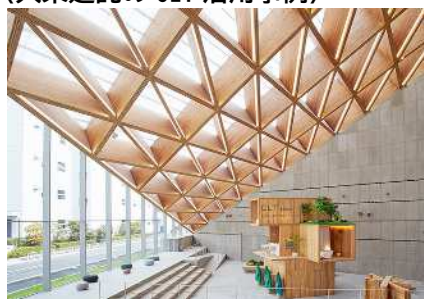
【ROOFLAG 賃貸住宅未来展示場】2020 年 6 月、国内最大級となる CLT の大屋根を持つ展示施設を東京都江東区にオープン
