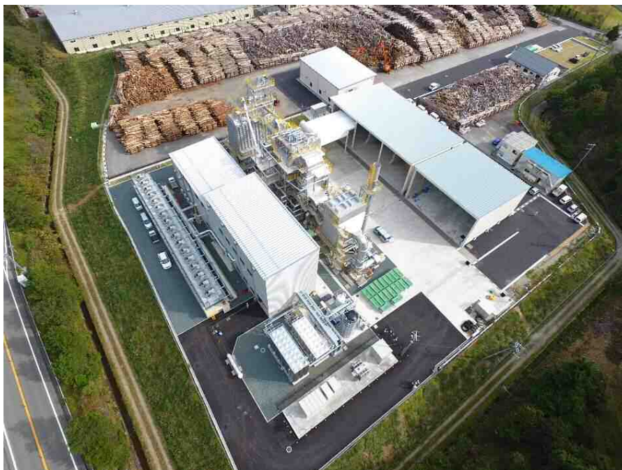
朝来バイオマス発電所、be材供給センター(俯瞰)
