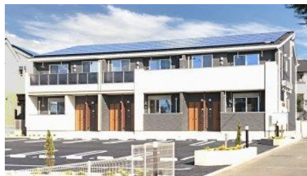
低圧一括受電システムを活用した日本初のZEH賃貸集合住宅(2017年11月完成)
