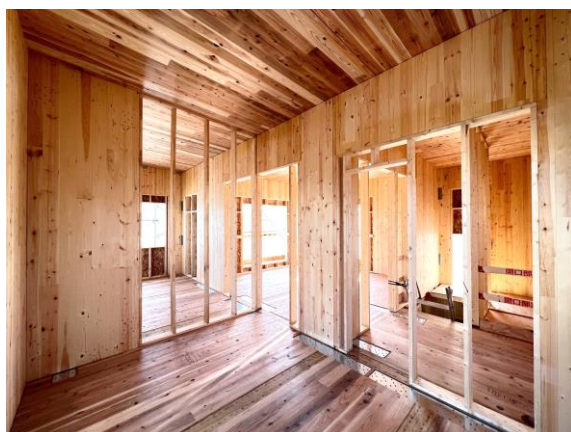
建設中の様子(2階・内観)
