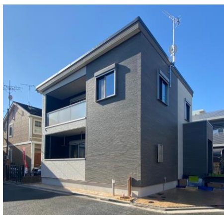
完成したCLTパネル工法の戸建賃貸住宅(外観)
