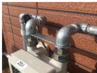
左:ガスメーター補強プレート
