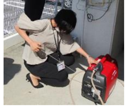
ガス発電機作動テストの様子
