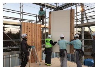
現場で耐火被覆付き CLTパネルを取り付け
