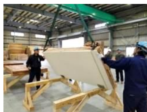
提携倉庫で耐火被覆取り付け
