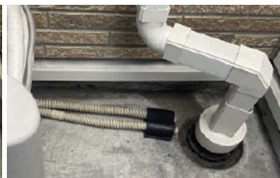
設置後の様子
