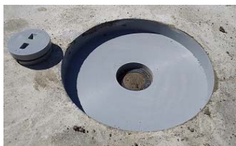
設置後の様子
