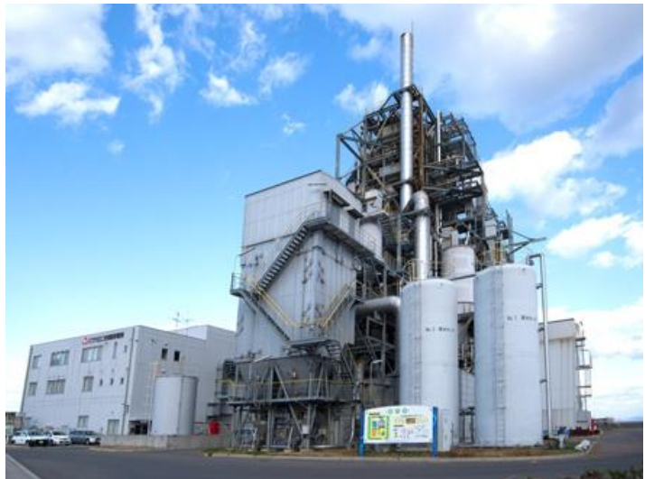
ミツウロコ岩国発電所(木質バイオマス発電)
