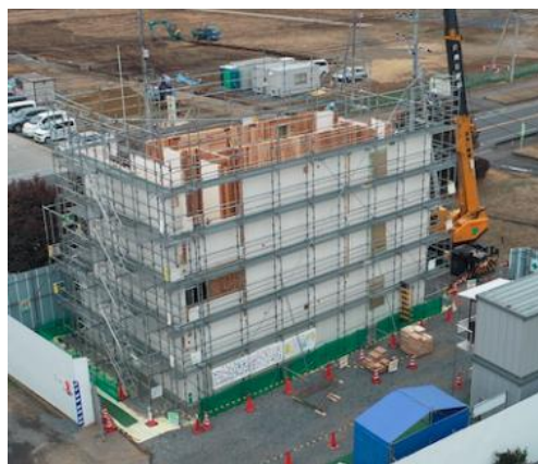
施工性などの検証を行った「CLT実大棟」
