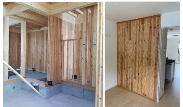
構造躯体をCLTとした建て方
