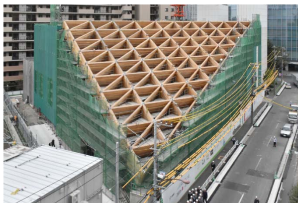
上棟したCLTの大屋根
