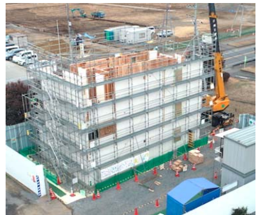
オリジナルCLT工法を検証する実験棟建築の様子
