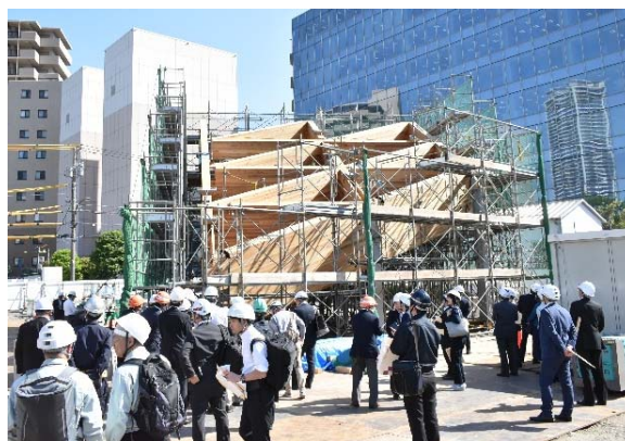
CLTモックアップ工事見学会の様子
