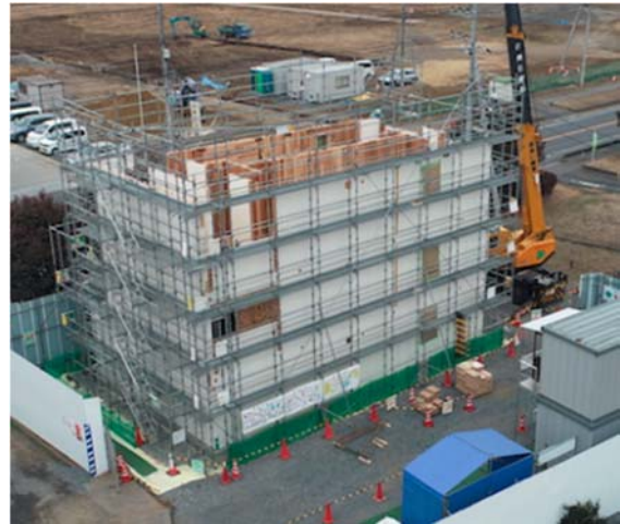
< オリジナルCLT工法を検証する実験棟 >
