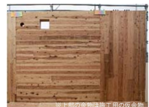
※上部の金物は施工用の仮金物 < 金物は壁パネル内に収納 >
