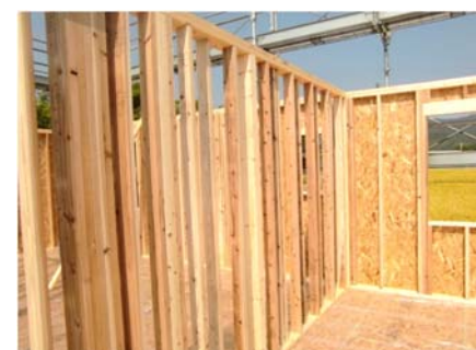
国産材を活用した建築現場 (2016年8月撮影/熊本県)
