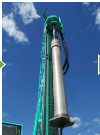
打ち込み前の杭全景
