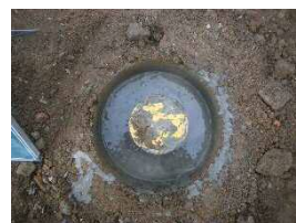
余った杭をカットし施工完了
