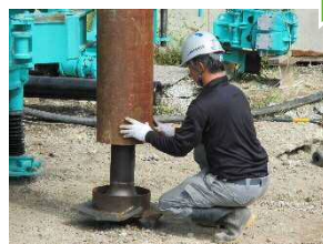
上記を杭打ち機に接続
