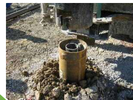
所定の地盤に杭が到達
