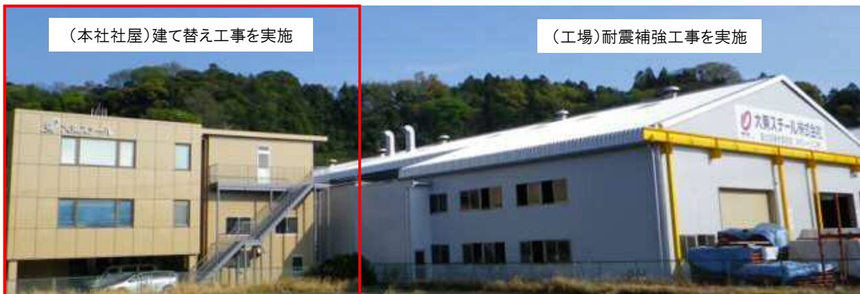
施工前写真(現大東スチール本社社屋と工場)
