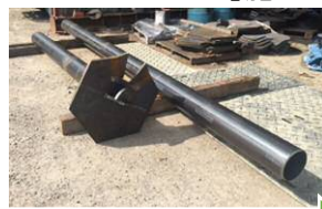
搬入された鋼管杭と先端翼
