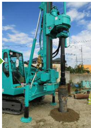
回転させながら杭を打ち込む
