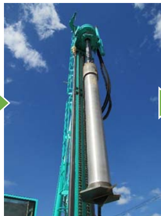
打ち込み前の杭全景
