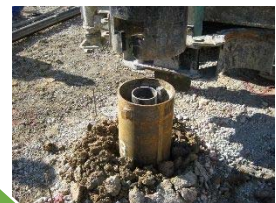
所定の地盤に杭が到達
