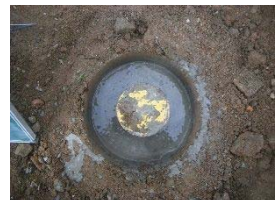
余った杭をカットし施工完了
