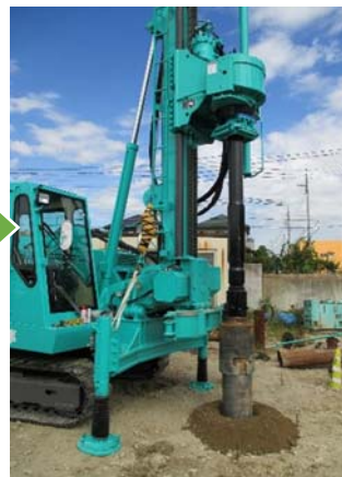
回転させながら杭を打ち込む
