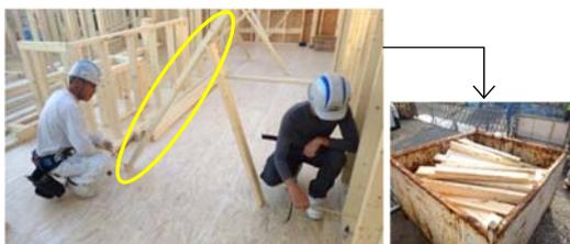
▲ 1人での作業は難しく、壁を建て起こす作業と、鉛直確認作業を分担して行うなど、工夫が必要でした
