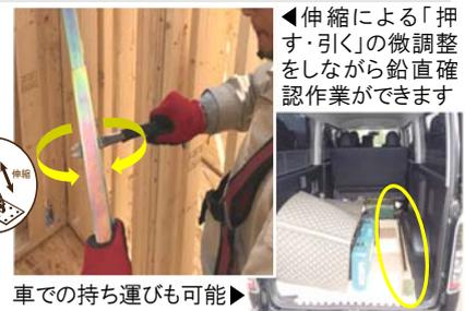
◀ 伸縮による「押す・引く」の微調整をしながら鉛直確認作業ができます
