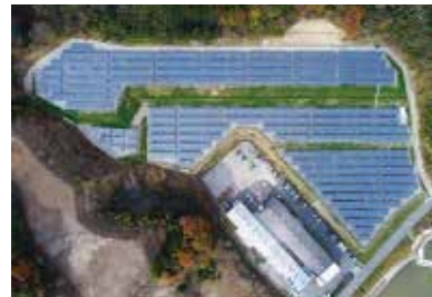
たつのメガソーラー発電所
