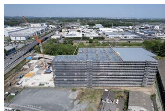
栃木県鹿沼市にて建設中の物流施設
