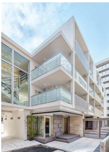
RC造地上4階地下1階建共同住宅
