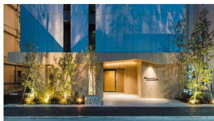
RC造15階建共同住宅 (エントランス)
