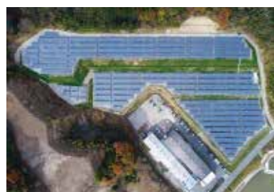
たつのメガソーラー発電所
