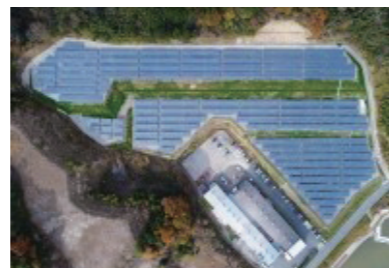
たつのメガソーラー発電所
