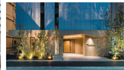
RC造15階建共同住宅（エントランス）
