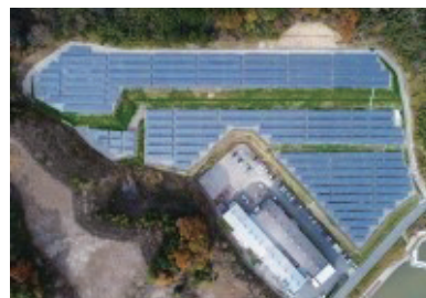
たつのメガソーラー発電所
