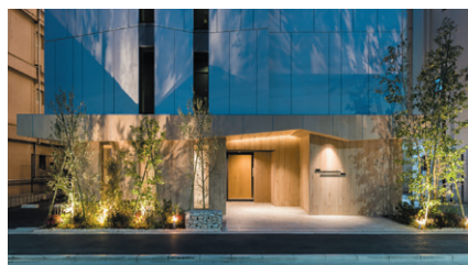
RC造15階建共同住宅 (エントランス)
