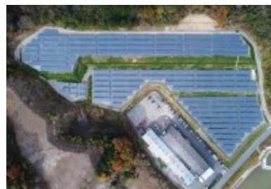
たつのメガソーラー発電所
