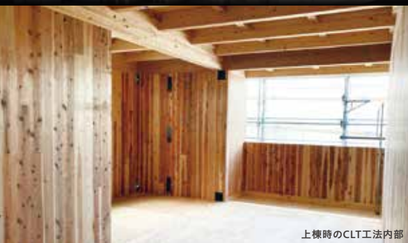
上棟時のCLT工法内部
