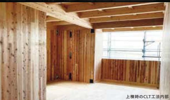
上棟時のCLT工法内部
