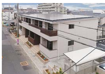
LCCM賃貸集合住宅(埼玉県草加市)
