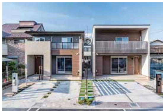
cocoDaTe 第1号棟・第2号棟(千葉県柏市)
