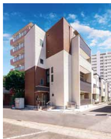
CLT賃貸集合住宅 第1号棟建物外観
