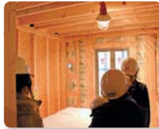
普段見ることのできない建築中の建物内部を見学
