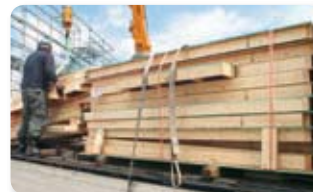
プレカット(切断・加工)され、工事現場へ
