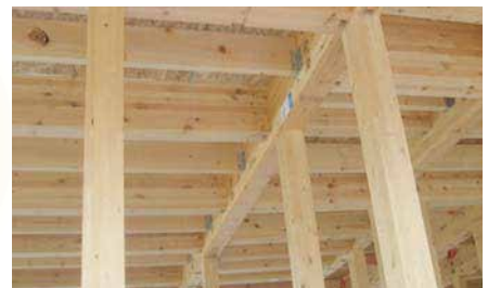
建築現場での組み立て
