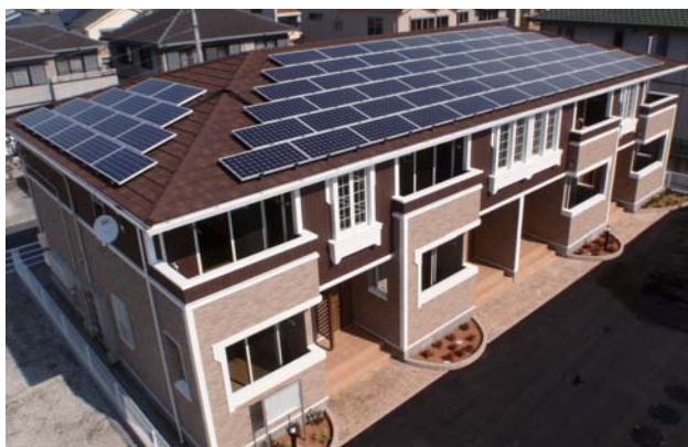
太陽光発電設備設置アパート
