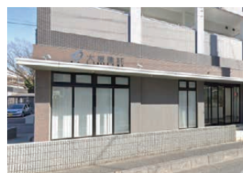
大東建託 浦和支店(埼玉県さいたま市)
