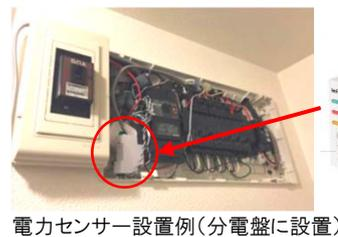
電力センサー設置例(分電盤に設置)
