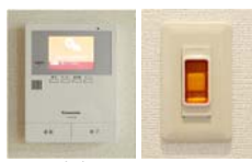
▲非常押しボタン&amp;録画機能付きTVインターホン
