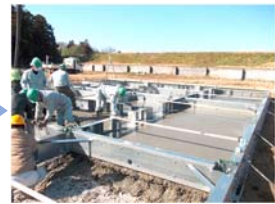
コンクリート打設
