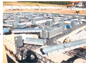
鉄骨ユニット組立
