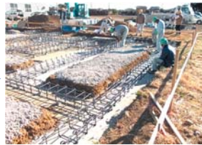
ユニット鉄筋組立
