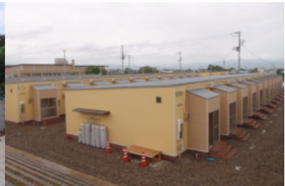
福島県会津若松市の仮設住宅
