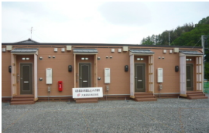
岩手県宮古市の仮設住宅
