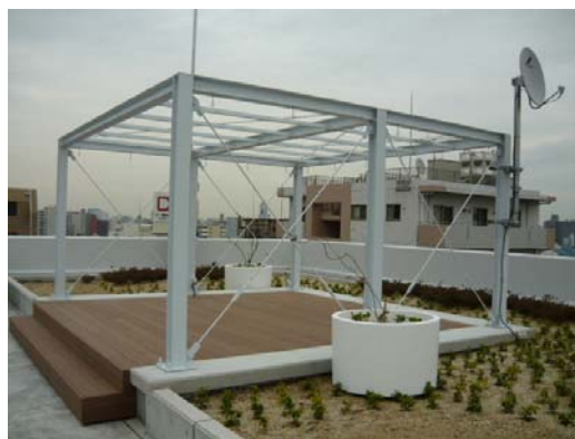
屋上に設置した藤棚とウッドデッキ
