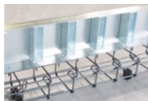
鉄骨・鉄筋の組み立て例
