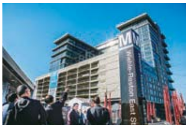
共同出資を行った 「BLVD | RESTON STATION」
