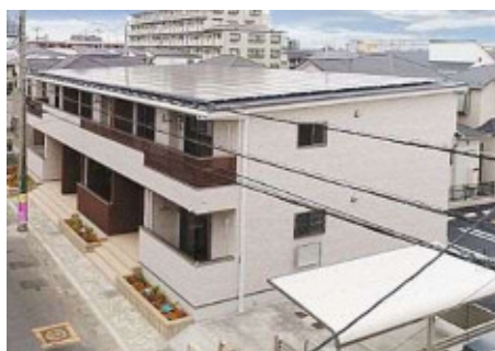
LCCM賃貸集合住宅の第1号棟 （埼玉県草加市）
